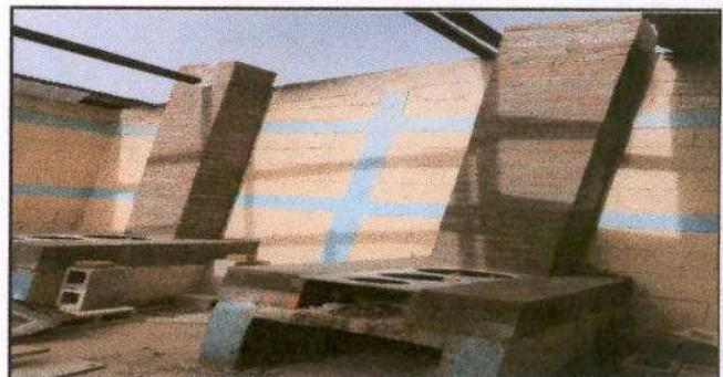
**Foto 6: Sustitución de chimenea de concreto**
